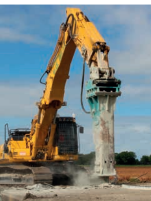
ABBRUCH VON STAHLBETONKONSTRUKTIONEN
