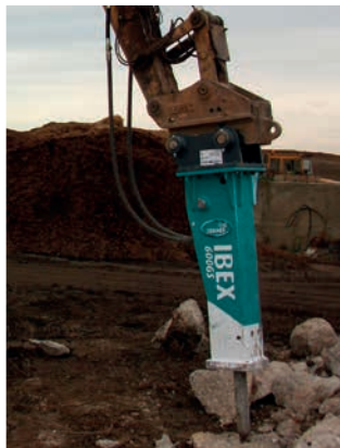
ABBRUCH VON GEBÄUDEN
