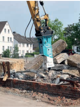
ABBRUCH VON BAUWERKEN
