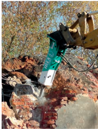
ABBRUCH VON MAUERWERK
