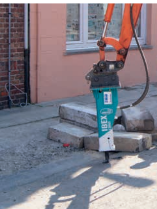
ABBRUCH VON GEHWEGEN (ASPHALT)
